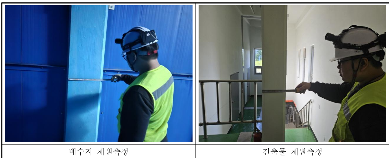
【사진 3.1】 시설물 외관조사
